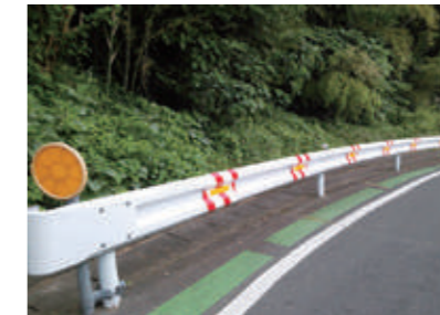
ガードレール支柱
