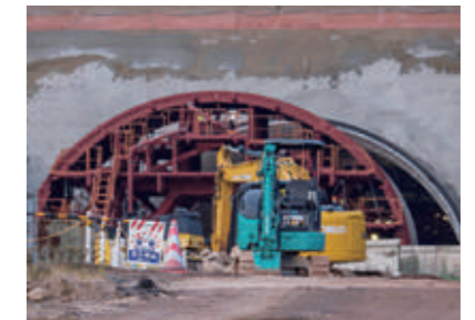
トンネル工事
